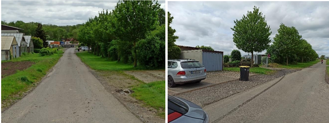
Abb. 3-7: Blick auf die Dörnberstraße aus Richtung Westen (linkes Foto, rechts die westliche Zufahrt zum Betriebsgelände Florin, entlang der Straße Grünstreifen mit hochstämmigen Feldahornen (Acer campestre) und aus Richtung Osten (rechtes Foto)
