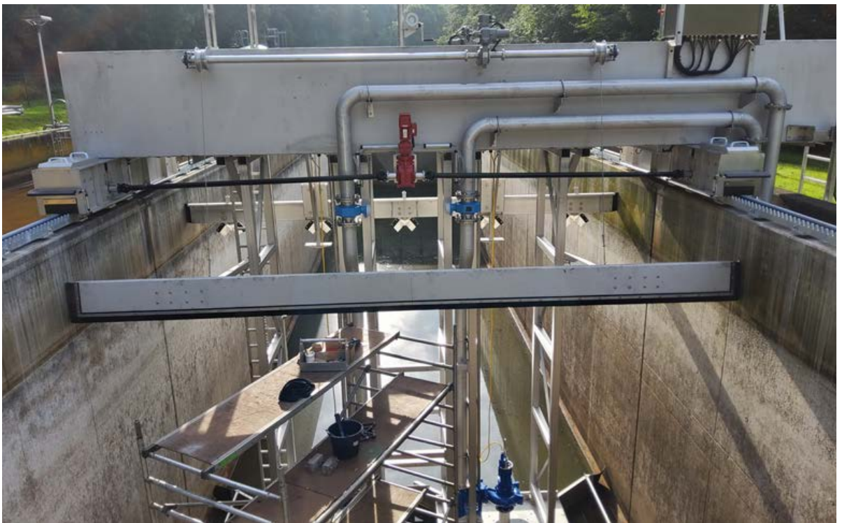
Energetische Ertüchtigung im Zuge der Erneuerung der beiden Nachklärbeckenräume auf der Kläranlage Simmershausen
