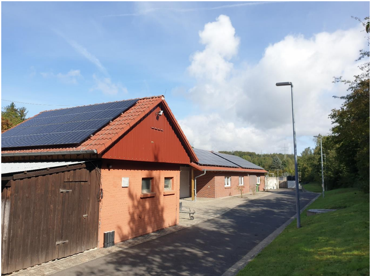
Dächer der Kläranlage Ihringshausen wurden 2023 mit PV-Anlagen ausgestattet
