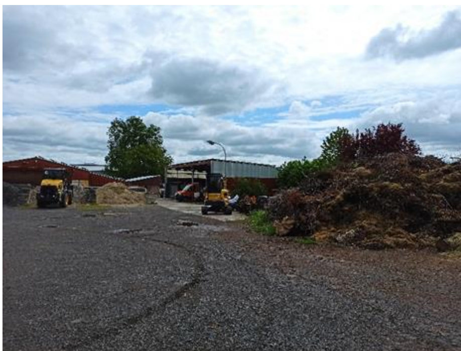
Abb. 3-6: Blick auf die Hallen auf dem Betriebsgelände
